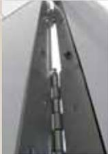
Bisagra completa con tetones antipalanca.
