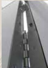
Bisagra completa con tetones antipalanca.
