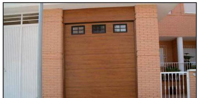
Seccional con tapa fija superior
